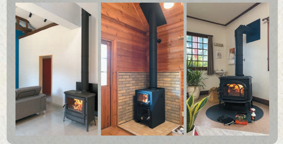
薪ストーブの施工例(2022年4月から9月にかけて)
