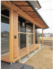
②緑側にはふとん干し用の手すりを付けました。
